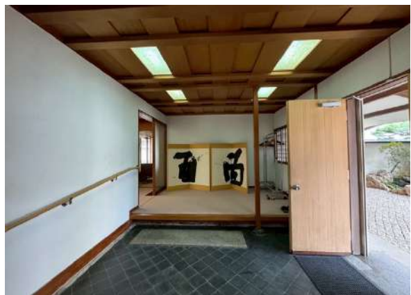
大和張りの天井を用いた玄関ホール
